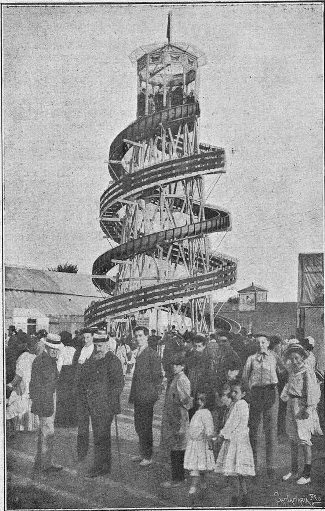
La construcción está sostenida por un caballete central que mide 18 metros de altura, compuesto de tres pisos: sobre él descansan las dos espirales de subida y bajada.
