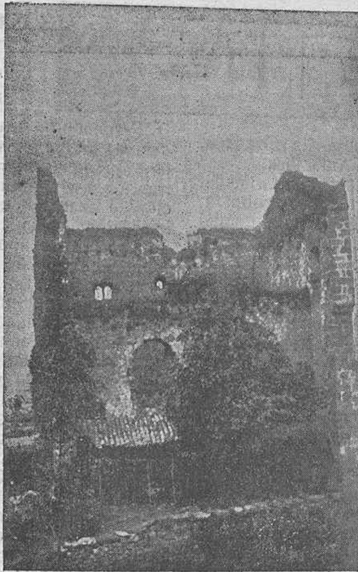
Vista de frente del palacio de "los Valdés", en su estado actual.
