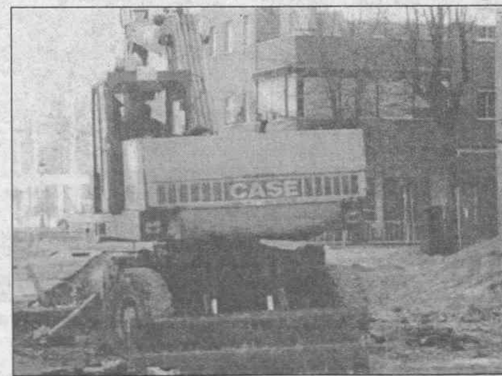
Las máquinas comenzaron con trabajos en el subsuelo.
