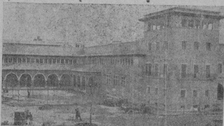
Vista de una de las alas y la galería de acceso a la pescadería
