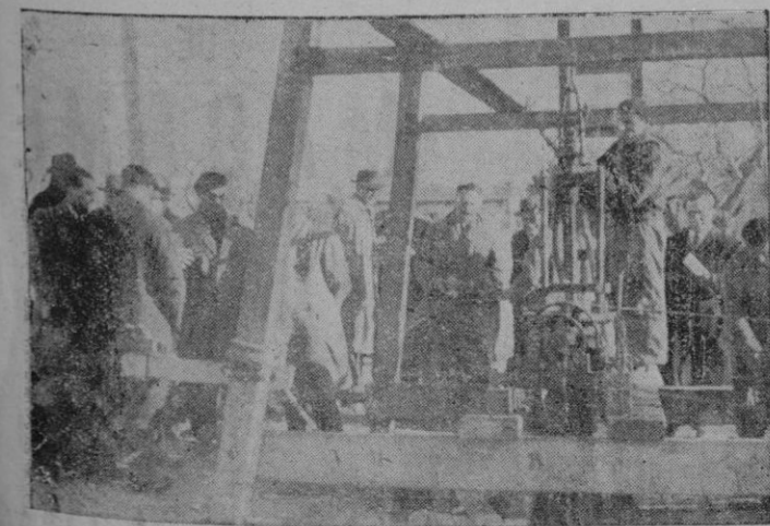
Los gestores presencian como los obreros extraen la pieza perforadora del sondeo
