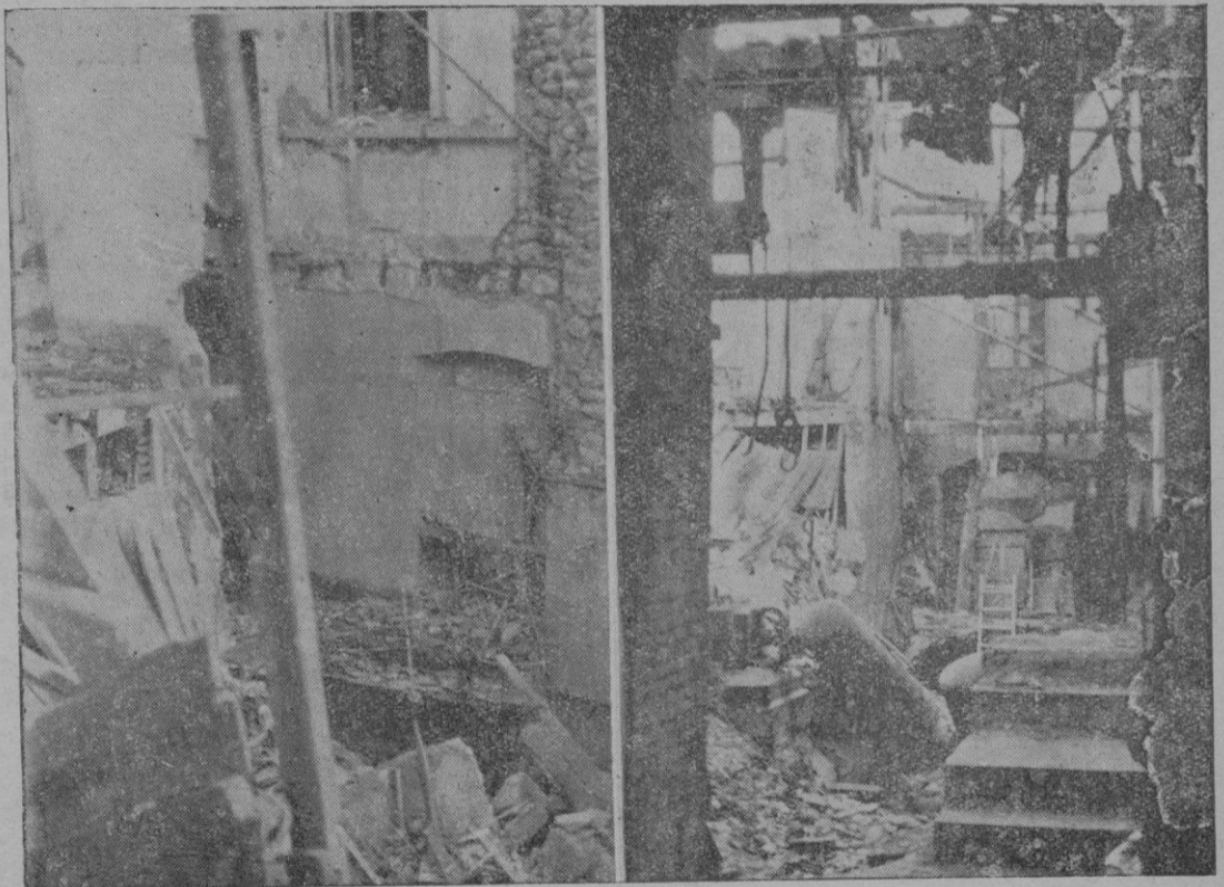
Dos aspectos parciales del estado en que quedó la fábrica de la Unión Textil de Sóller después de la explosión ocurrida anteaño.
