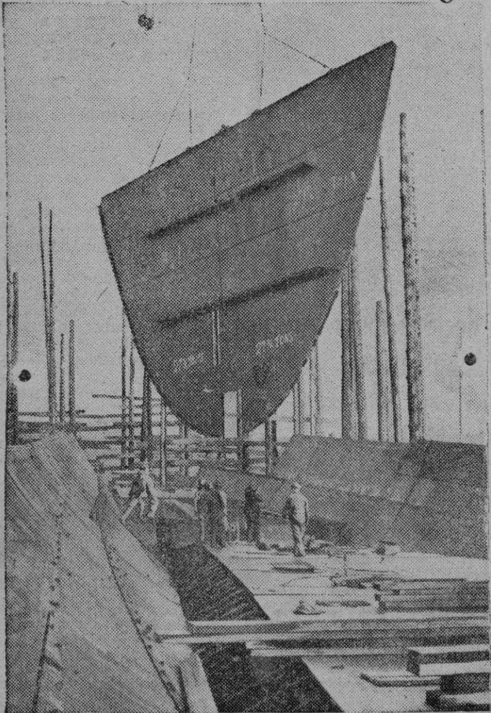
En enero de 1946 se empleó por vez primera piezas de buques prefabricadas en la construcción del "Orcades". Este nuevo método significa un ahorro de 900 toneladas de acero en la construcción de buques de esta clase; un aumento en la capacidad de carga hasta 2.000 toneladas aproximadamente; reduce la vibración y, además, ahorra un 25 por ciento de tiempo en la construcción de los mismos.
