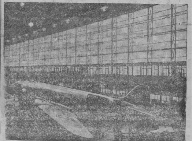
La mayor ventana de cristal del mundo, 305 metros de largo y 15'25 metros de alto, representada en el grabado es la del taller de montaje de «Brabazon», el nuevo aeroplano británico, calculada para resistir galernas de una velocidad superior a 125 kilómetros por hora, no desconocidas en el Canal de la Mancha.—(Calpe)
