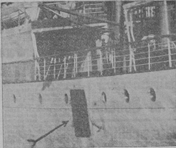
El imponente vendaval motivó el abordaje de los dos buques, quedando completamente roto el portillo de estribor del entrepunto, avería que rápidamente fué reparada mediante la plancha de hierro que señala la flecha
