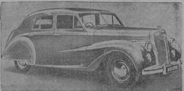
En la fotografía puede verse un modelo del nuevo Austin Princess «120» de 16 HP, seis asientos, cambio de marcha en la columna de conducción, suspensión independiente de ruedas delanteras y otros refinamientos.
