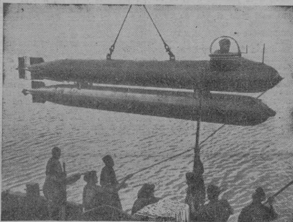
Contra los barcos de la invasión emplean los alemanes con gran éxito el torpedo humano o tripulado. En la parte superior vemos la lancha conductora con la cúpula de «Periglas», en la que va el tripulante. En la parte inferior el torpedo que, propulsado eléctricamente, se separa de la lancha al hallarse a corta distancia del objetivo.
