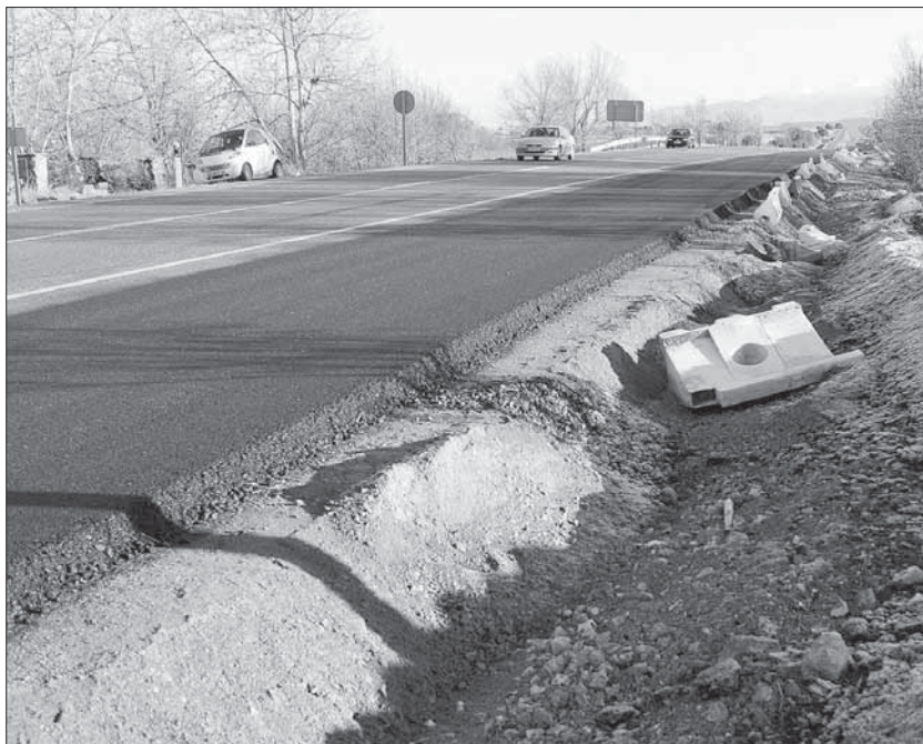
La actuación entre El Panorámico y La Losa se extiende por casi un kilómetro. / FERNANDO PEÑALOSA
