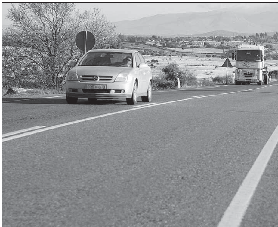
Las obras de reforma del firme de la N-603 comenzarán previsiblemente después la próxima Semana Santa y tienen como objetivo mejorar la
