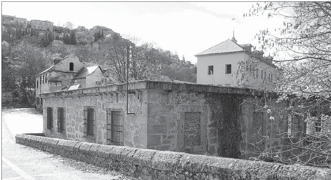
Las obras de rehabilitación de la Casa de la Moneda, con un coste por encima de los siete millones de euros, podrían comenzar en primavera. / FERNANDO PEÑALOSA
