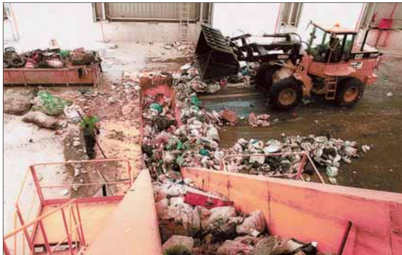
La actual planta de residuos fue contruida por error sobre terrenos que no eran propiedad del Consorcio // JUAN MARTIN
