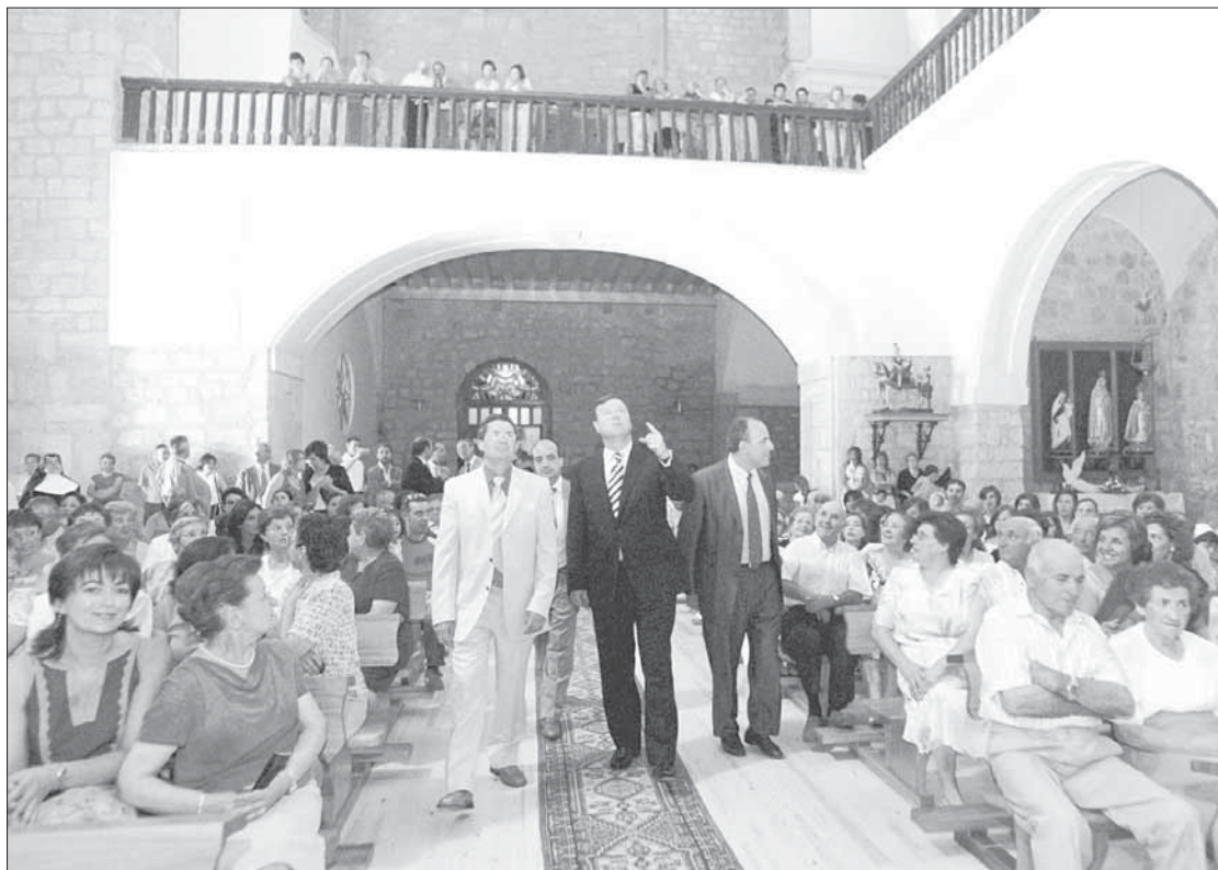
El consejero de Fomento visita las obras de restauración de la iglesia de Cevico de la Torre (Palencia). / SARA MUNIOSGUREN
