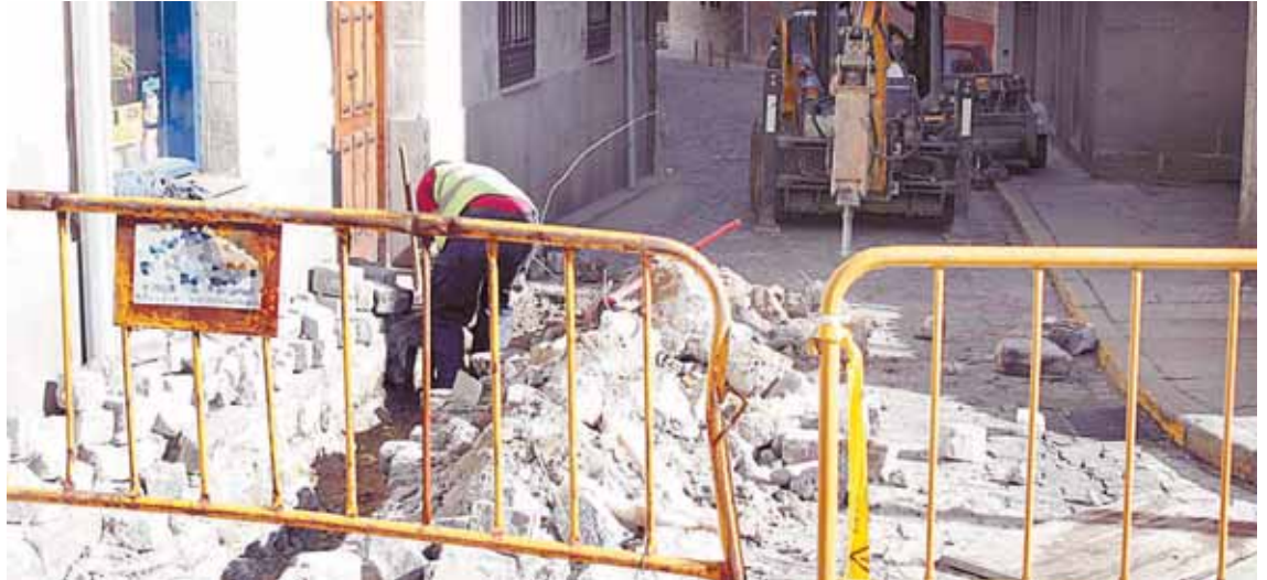
Obras en el centro. 2006 registrará varias actuaciones tanto en edificios de nueva planta como en rehabilitación y obras de pavimentación y saneamiento /F. PEÑALOSA
