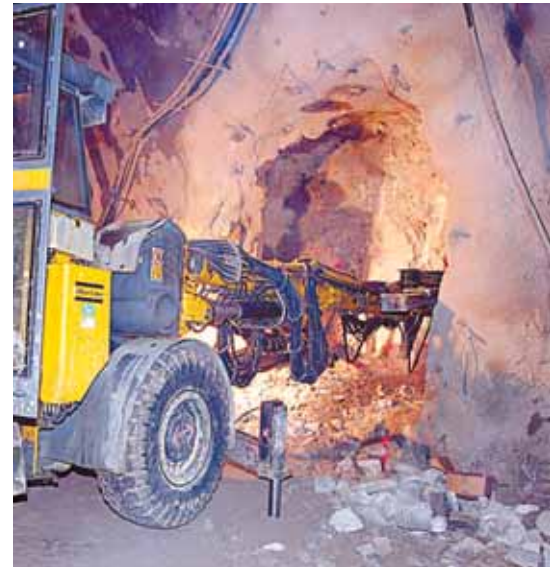
Perforación del Tercer Túnel de Guadarrama para la AP-6 / FERNANDO PEÑALOSA
