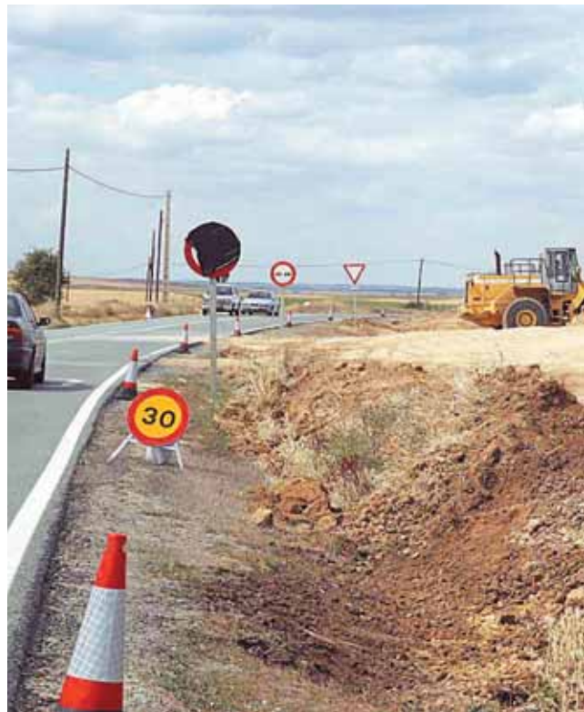
Obras de acondicionamiento en la Carretera CL-601, que la Junta de Castilla y León va a convertir en autovía.
