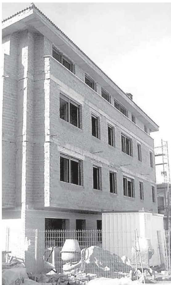
Un bloque de pisos en construcción. / JOSÉ LUIS ACEBES
