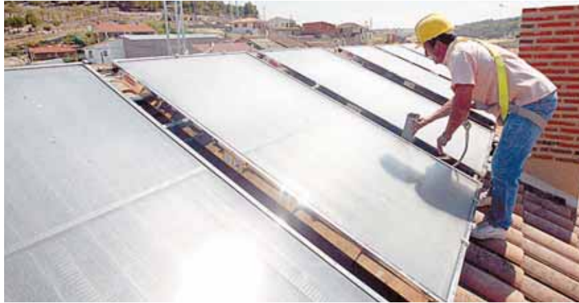
Instalación de paneles solares en una localidad rural de Castilla y León / I.CAL
