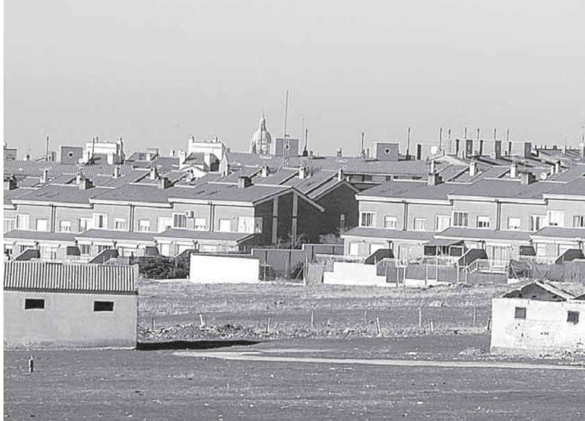
Viviendas de nueva construcción en una localidad del alfoz de Segovia, adquiridas generalmente por parejas jóvenes / KAMARERO
