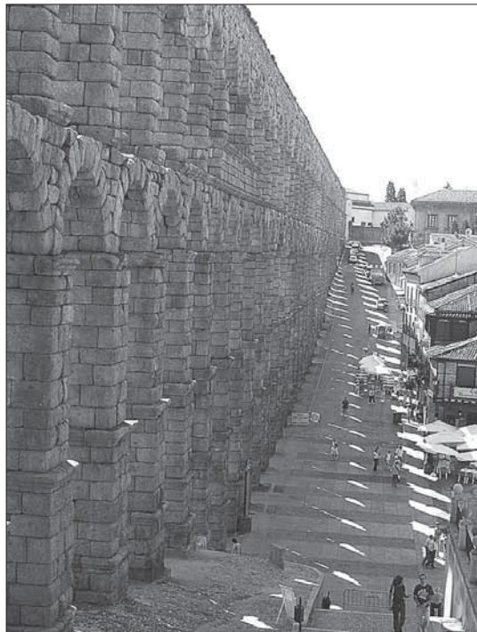
La última restauración del Acueducto finalizó en el año 2000/JUAN MARTÍN
