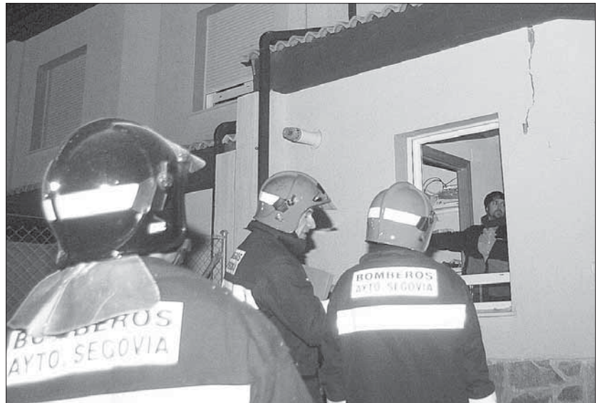
Los bomberos de Segovia se acercaron hasta el lugar del suceso para inspeccionar el estado de la vivienda. / KAMARERO
