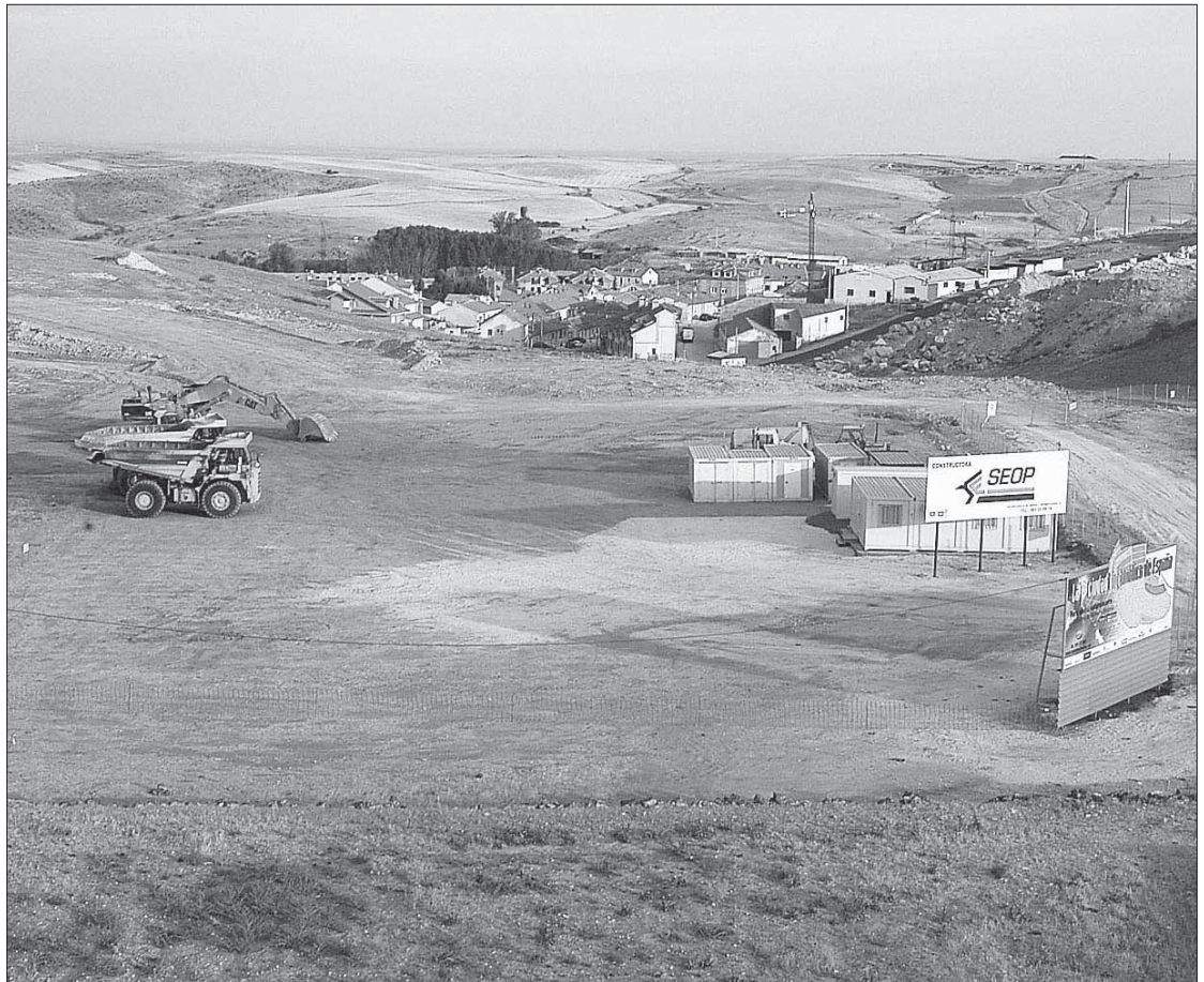
Vista parcial del lugar elegido para el desarrollo del proyecto de ciudad bioclimática de Bernuy de Porreros. / JUAN MARTÍN
