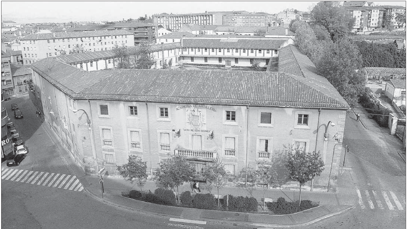
El campus ocupará 14.500 metros cuadrados de terrenos delimitados por las calles Coronel Rexach, Caño Grande, Sargento Provisional y la plaza de los Leones de Castilla/JUAN MARTIN
