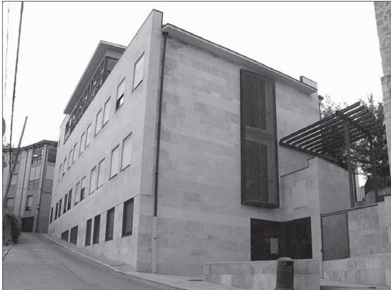
Las actuales instalaciones sanitarias tienen graves problemas de espacio
