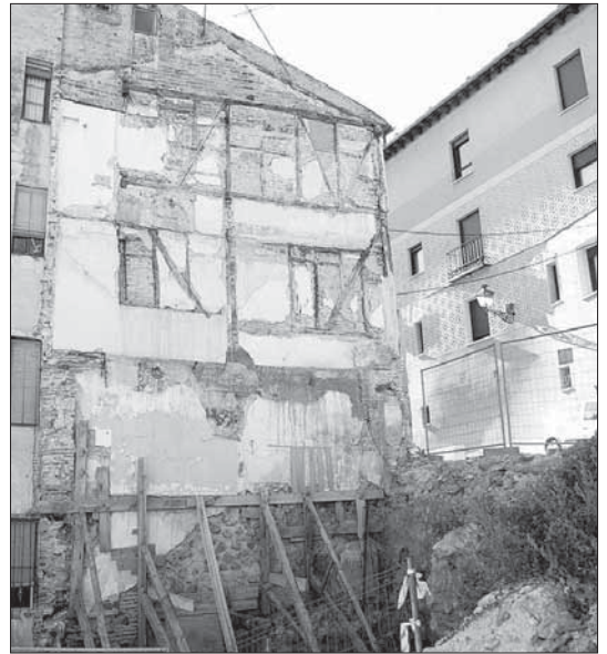
Aspecto parcial de las viviendas demolidas
