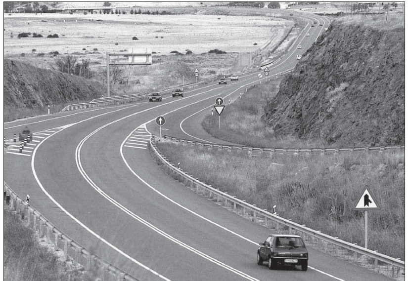
El presupuesto de los trabajos que se realizarán asciende a casi cuatro millones de euros
