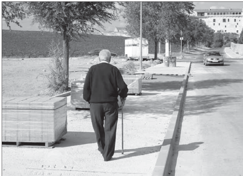
Estado actual de las obras de construcción de la acera del camino del Alamillo
