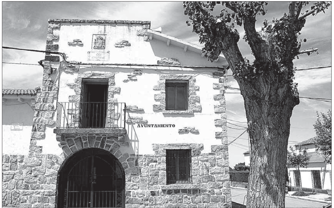
El Ayuntamiento de La Losa, construcción en piedra, similar a otros edificios de esta zona serrana
