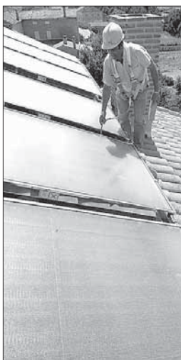
Un operario coloca paneles solares.
