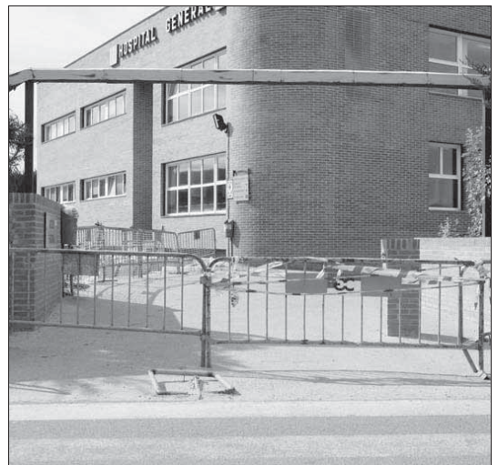
La antigua entrada principal se encuentra clausurada
