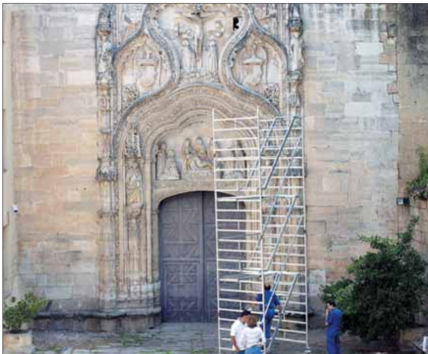
Los primeros trabajos de consolidación comenzaron en la mañana de ayer
