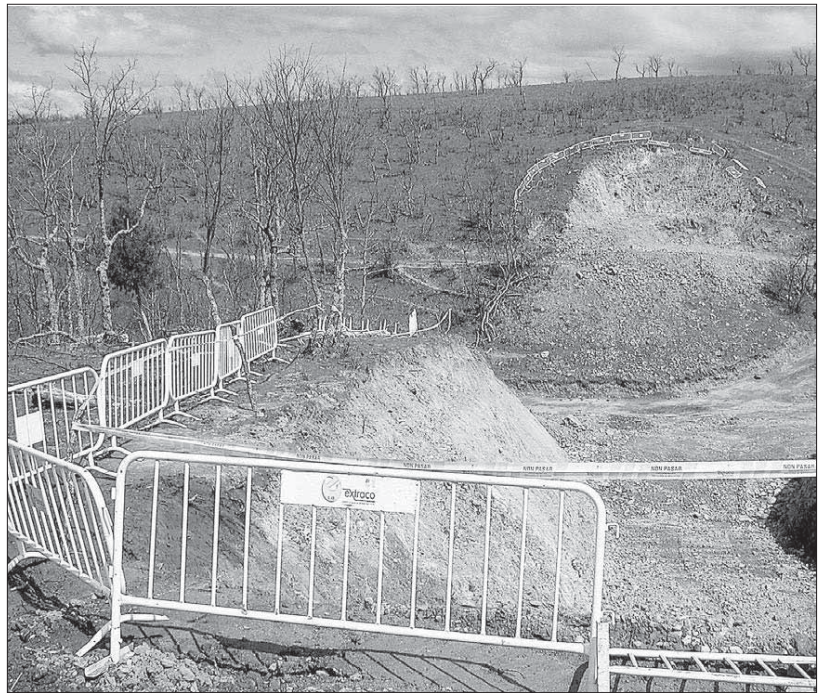
El Gobierno Regional inició las obras de construcción de la presa, paralizadas después
