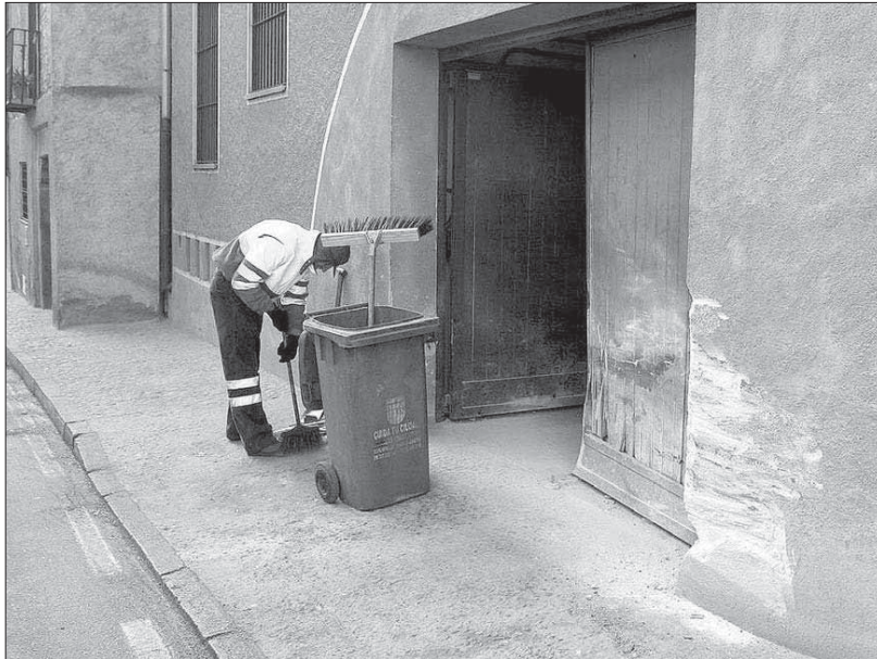
Estado en el que quedó el edificio contra el que se empotró un vehículo en diciembre pasado
