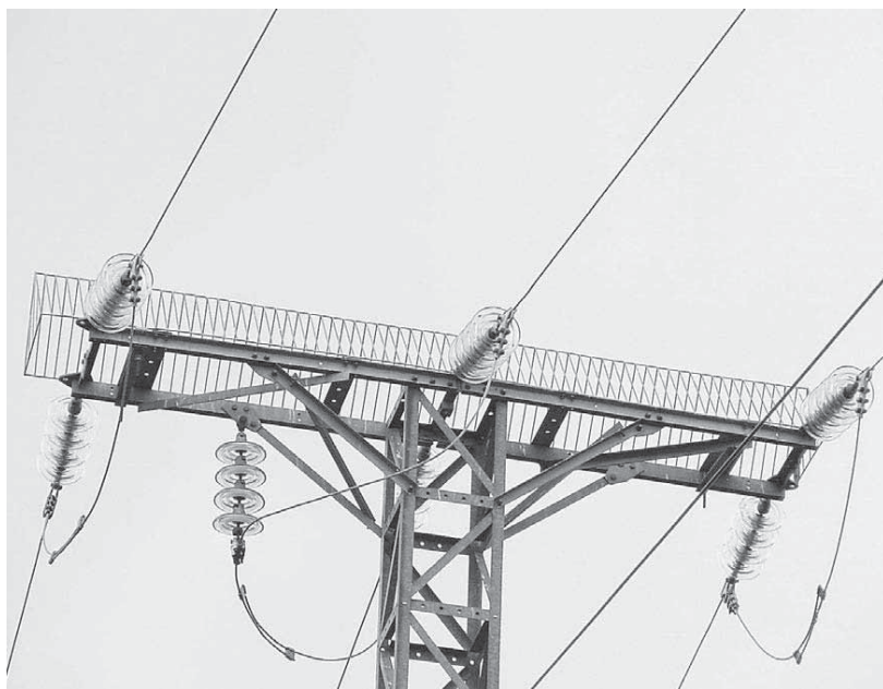
Las compañías eléctricas colocan estructuras para evitar la reconstrucción de los nidos
