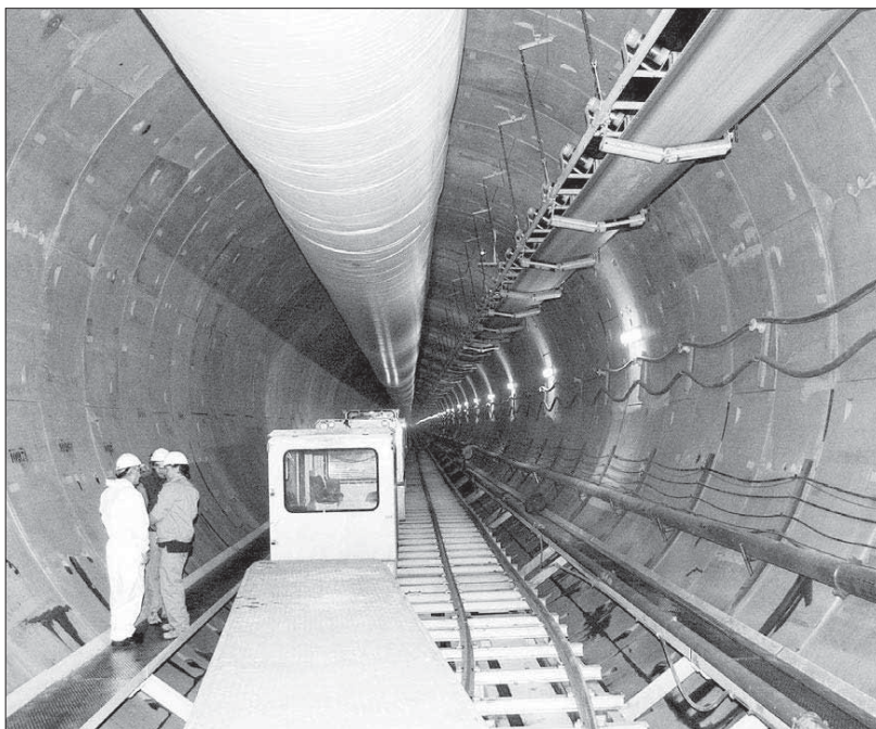
El tubo oeste del túnel, en la fotografía, fue concluido el pasado mes de mayo
