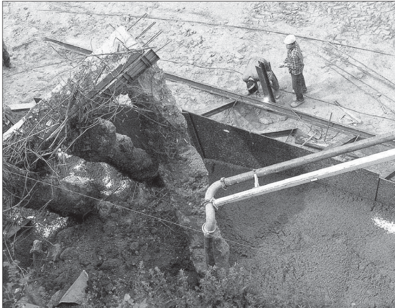
El contrafuerte de hormigón servirá para garantizar la seguridad del talud
