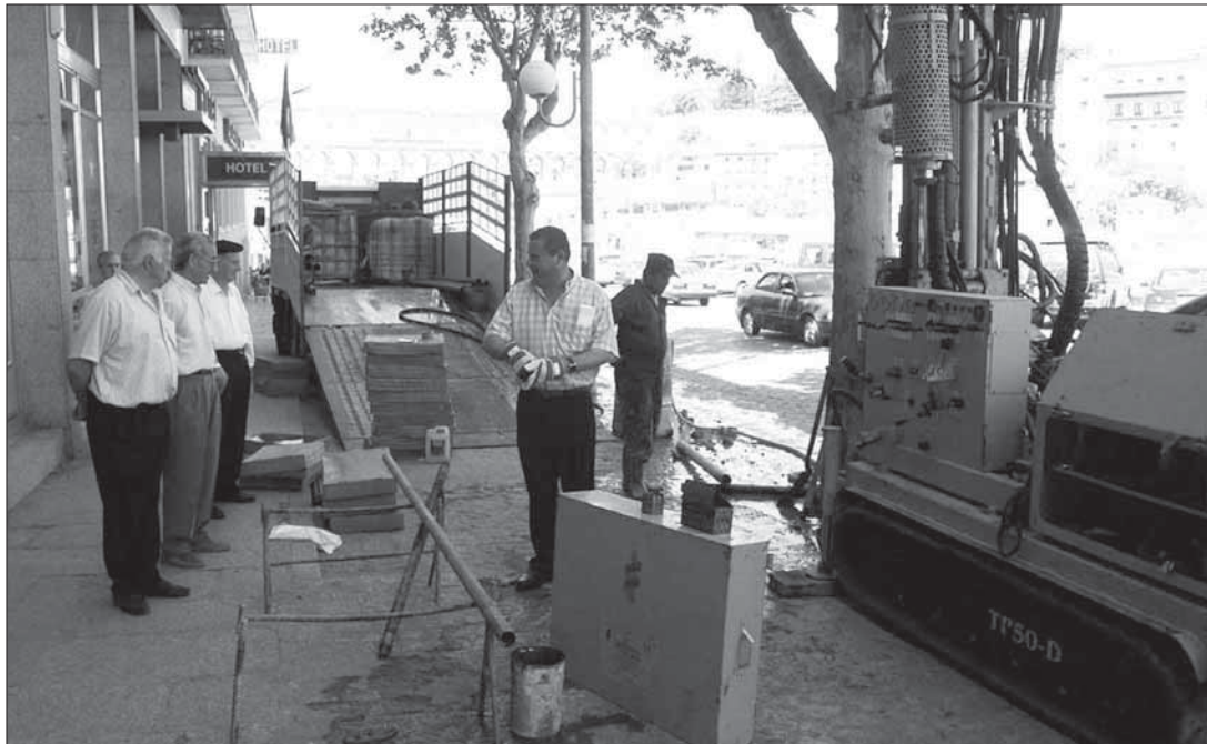
Con la ayuda de una gran máquina, varios operarios comenzaron ayer a tomar "catas" del terreno de la avenida Padre Claret
