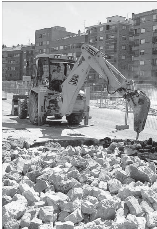
Los trabajos han comenzado con la demolición de pavimentos J.MARTIN
