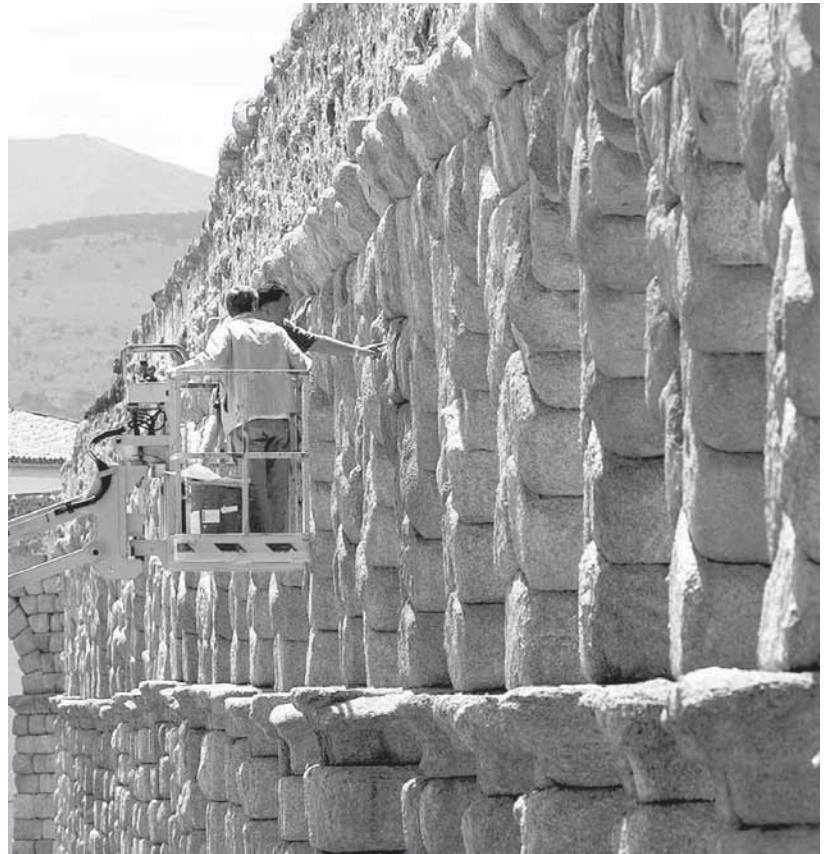
Dos restauradores revisaban ayer los sillares con una grúa asentada en la Plaza Oriental
