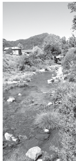
Se acondicionarán las márgenes de los ríos para prevenir avenidas
