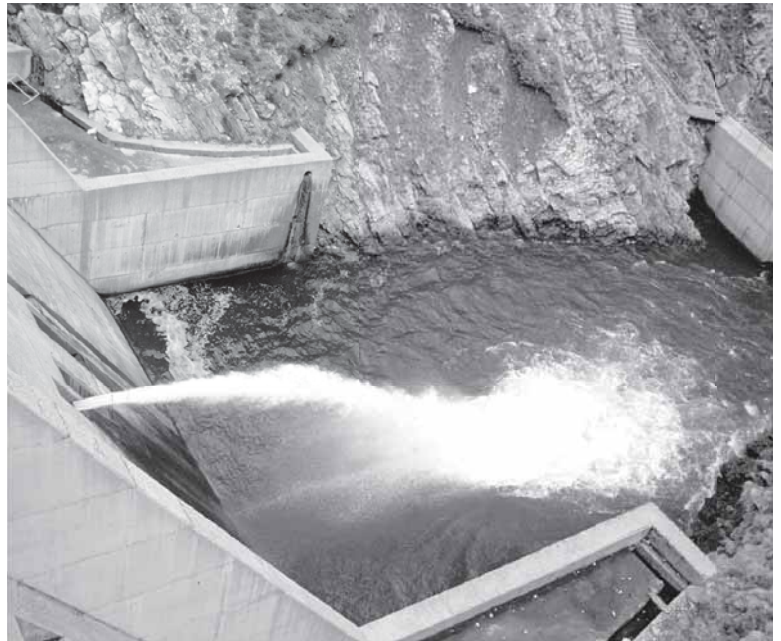
La energía hidráulica está consolidada pero prácticamente ha tocado techo
