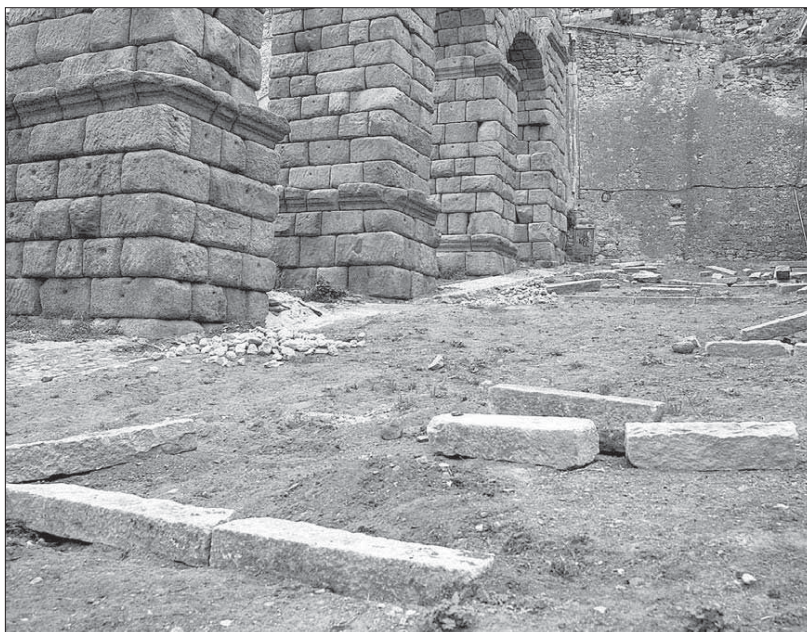
Los trabajos, ya iniciados, se prolongarán durante los próximos días
