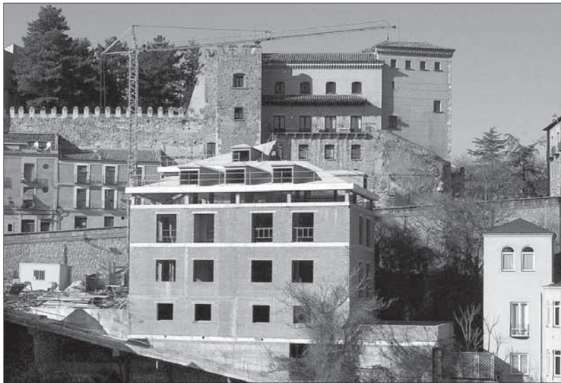
Las obras en el edificio de Unión Previsora fueron paralizadas por la Junta el 29 de diciembre. JUAN MARTÍN
