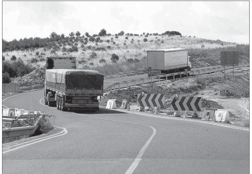
Las obras de acondicionamiento de la carretera empezaron hace unos meses
