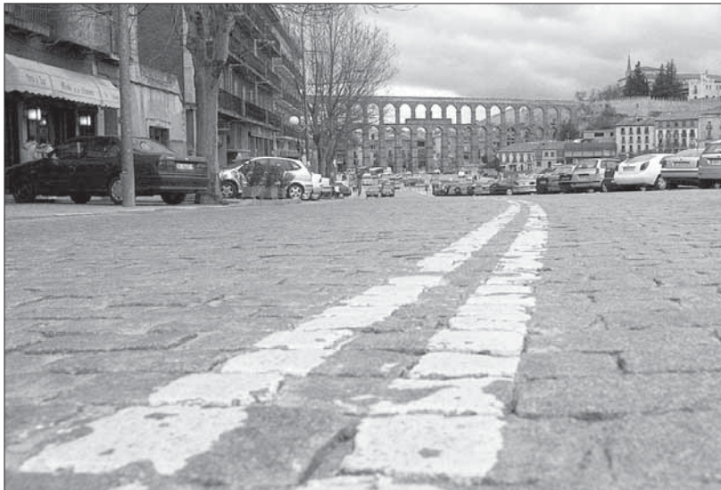
El parking discurrirá bajo el subsuelo de la avenida de Padre Claret
