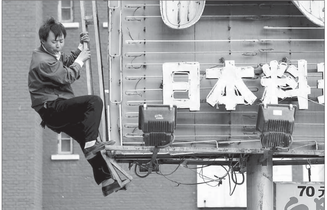
Un operario instala nuevos fluorescentes en el cartel luminoso de un restaurante japonés que resultó dañado por actos vandálicos. / M.R. (EFE)
