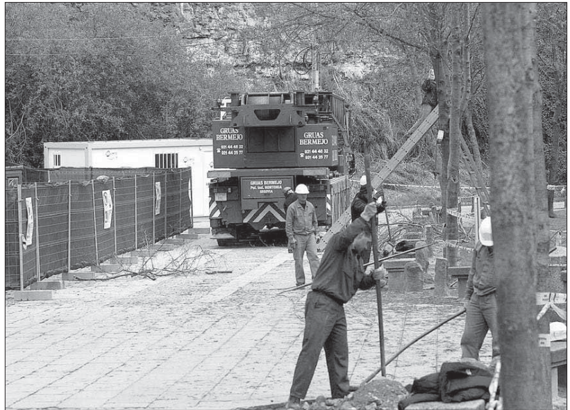
Los operarios de la empresa Construcciones Ortiz coordinan los primeros trabajos en la zona. JUAN MARTÍN
