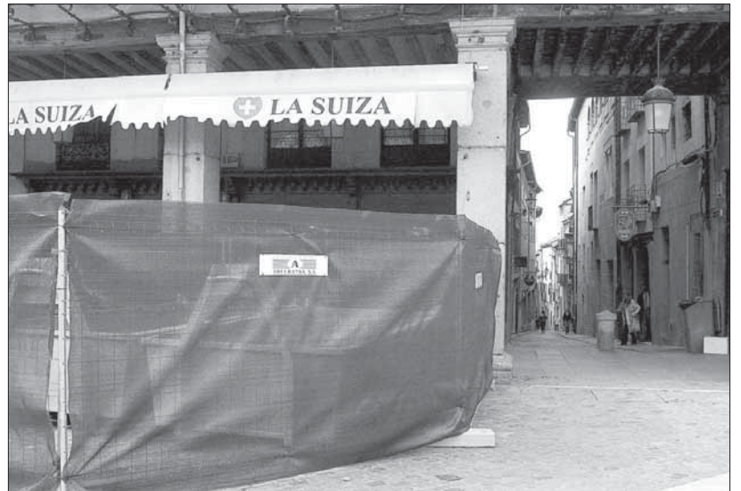
La semana pasada la empresa ya depositó varios contenedores al servicio de la obra
