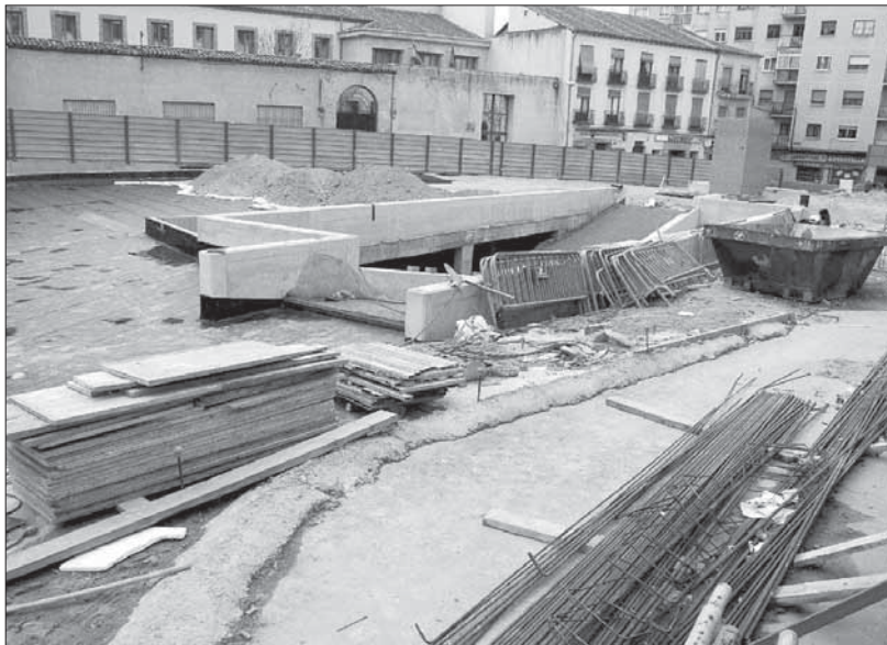
Collosa-Pygsur trabaja ya en la última fase de construcción del aparcamiento
