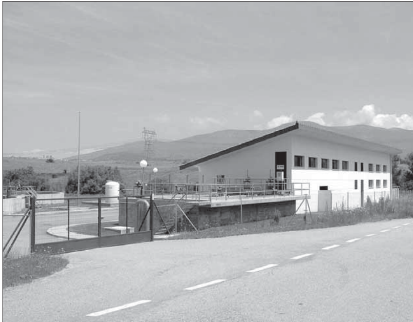
Imagen de la depuradora de El Espinar, que obligó a iniciar el expediente de expropiación PEDRO L. MERINO
