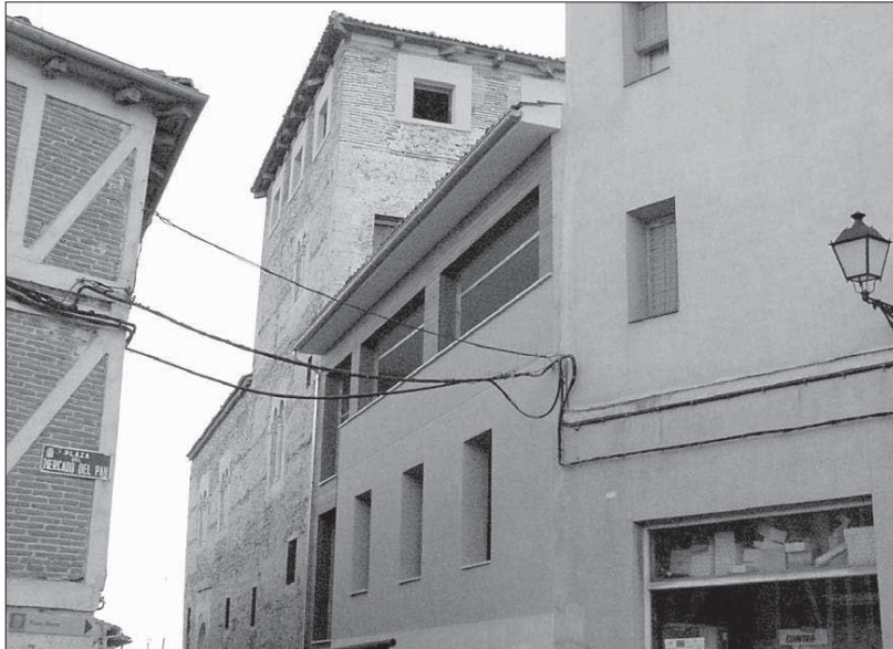
Las obras de adaptación del Palacio de Pedro I como sede del vivero están a punto de concluir GABRIEL GÓMEZ
