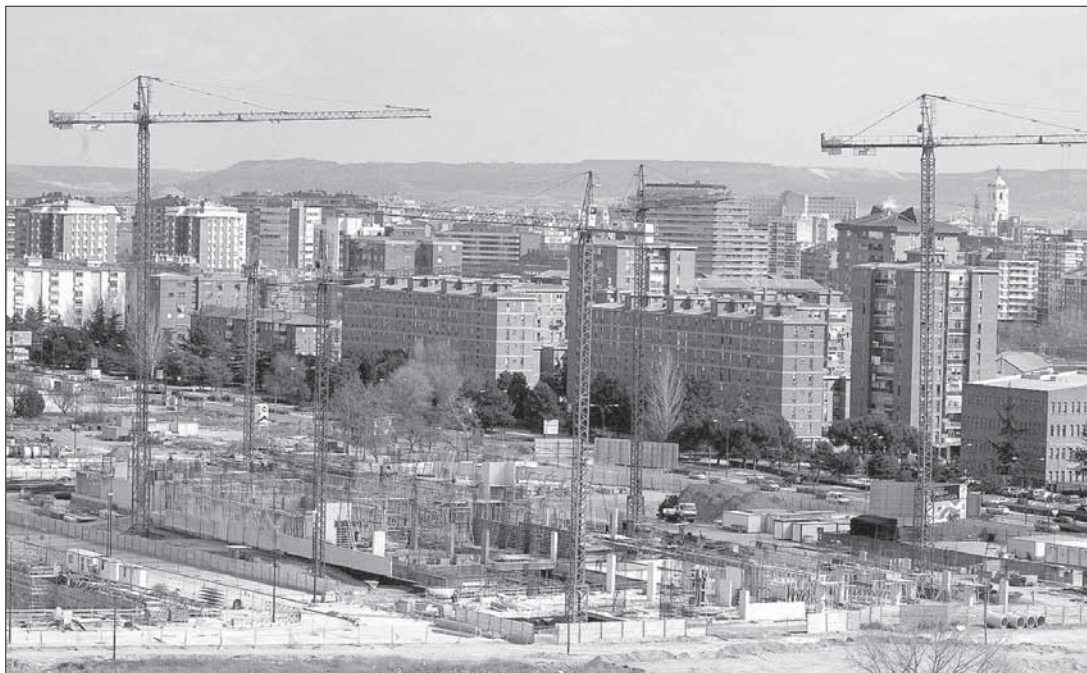
Imagen de las obras de la nueva sede del Parlamento regional, que se ubicará en Villa del Prado, en Valladolid. / LETICIA PÉREZ (ICAL)
