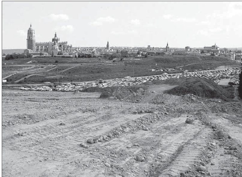
Imagen tomada cuando se realizaron los trabajos de explanación de la parcela
