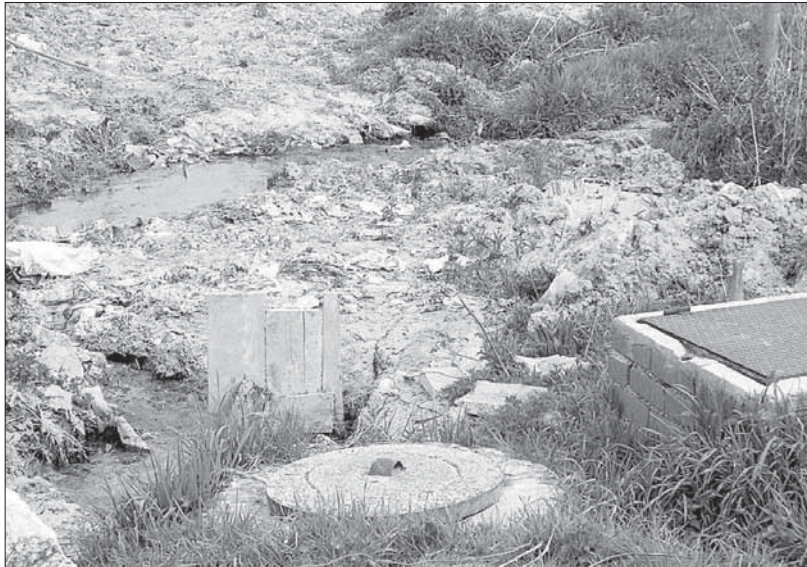
Las obras mejorarán algunas infraestructuras de saneamiento ya obsoletas
