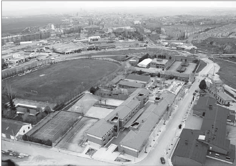
Imagen aérea de las instalaciones de Baterías, junto a la carretera de Madrid
