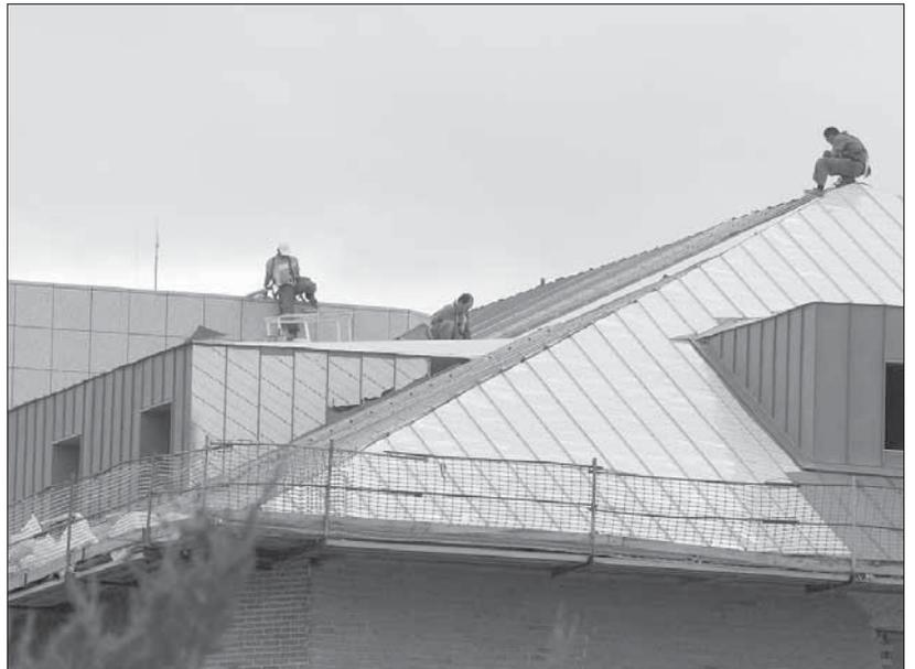
Imagen de los trabajos de reforma de las cubiertas que se han llevado a cabo en el hospital EL ADELANTADO
