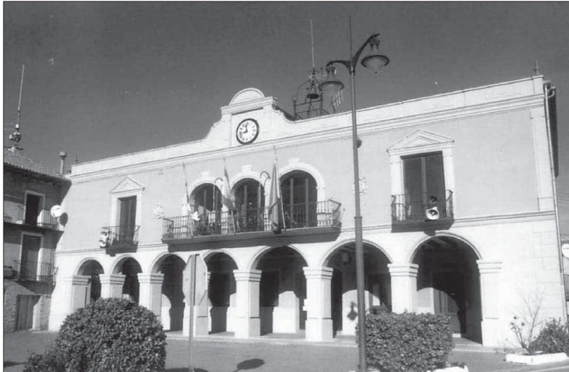
Estado actual del Ayuntamiento de Santa María tras las obras
