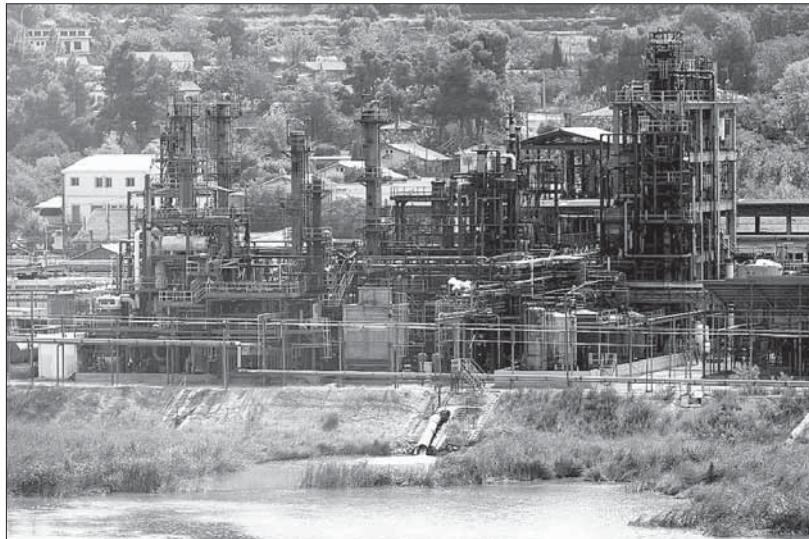
Fábrica de la empresa Ercros en Flix, a orillas del Ebro. En el centro de la imagen se aprecia una tubería de desagüe. / EFE
