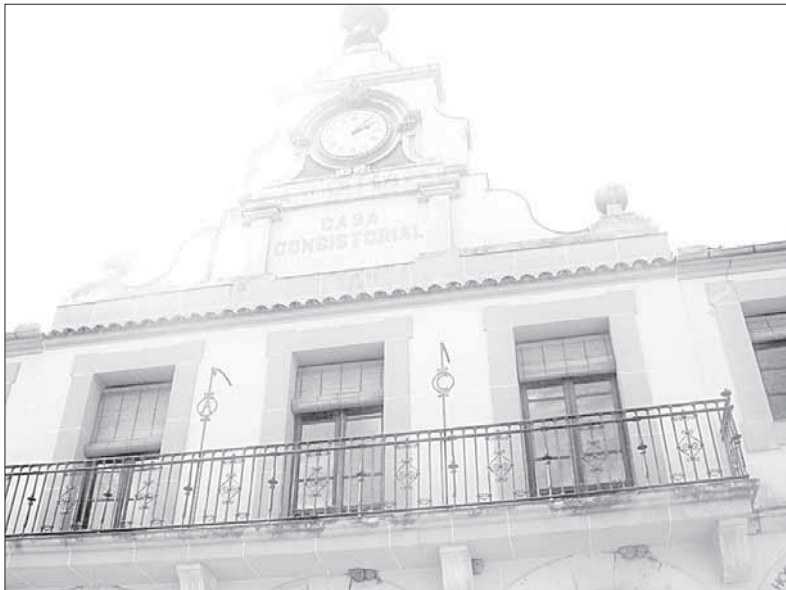
Fachada del edificio que alberga las oficinas municipales, que será remodelado
