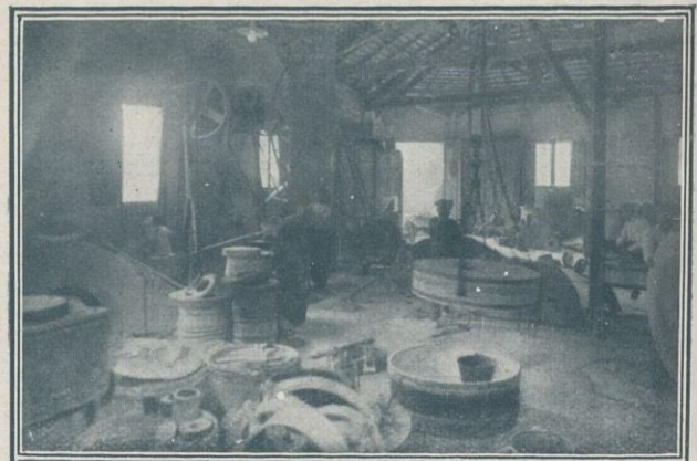
Aspecto de la sección de fábrica de piedras Mayol
