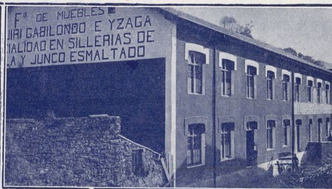
Exterior de la Fábrica
