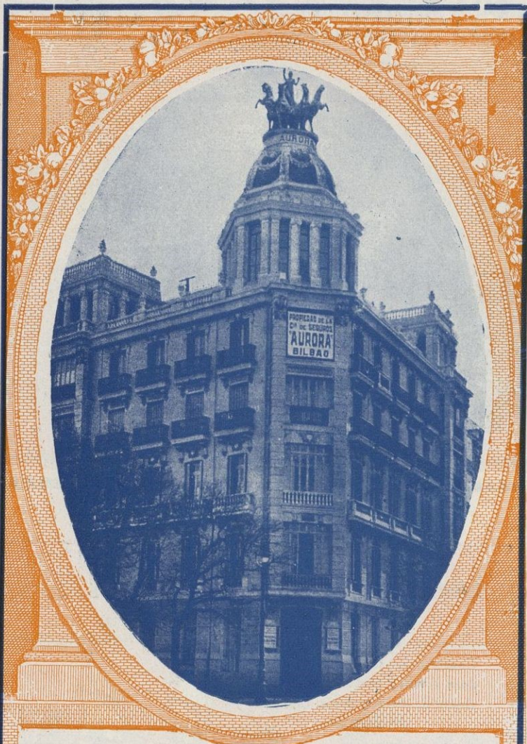
Edificio propiedad de la Compañía en Madrid Paseo de Recoletos
